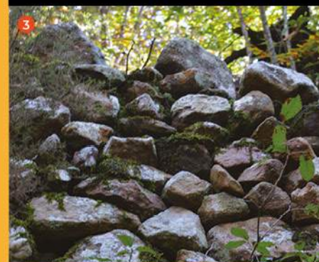
Particolare dei muretti a secco costruiti lungo il sentiero
